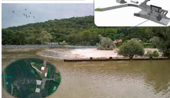
impliquent également la démolition de 2 anciens bâtiments de l'îlot et d'importants terrassements avec notamment le reprofilage et le confortement de la berge à l'amont du barrage.
