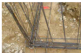
Nœud de chaînage - Continuité mécanique
